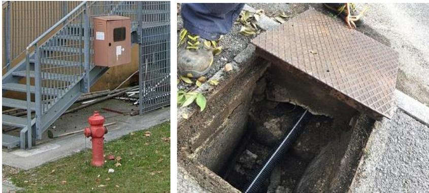
Inoltre è presente una rete di messa a terra con cavi in rame collegata all'edificio e pozzetti di ispezione.
