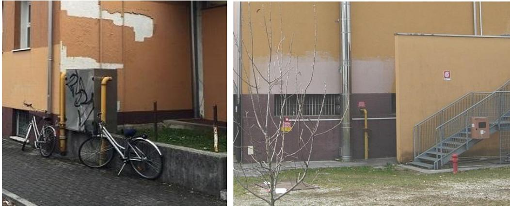
Inoltre, è possibile un'interferenza con la rete idranti esterna con la formazione delle travi di fondazioni perimetrali in ampliamento, che potrebbe richiedere una rettifica delle tubazioni interrato. Non sono previste altre modifiche all'impianto termo-idraulico.
